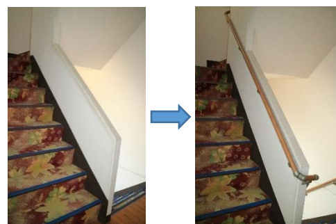
鳥羽市内民宿 階段手すり取り付け
